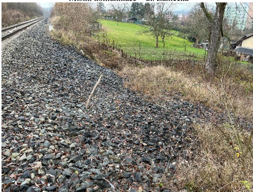
Pokračující sesuv v km 25,915
