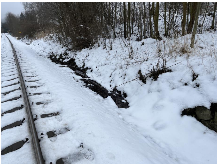
km 26,050, nefunkční odvodnění v zářezu vpravo
